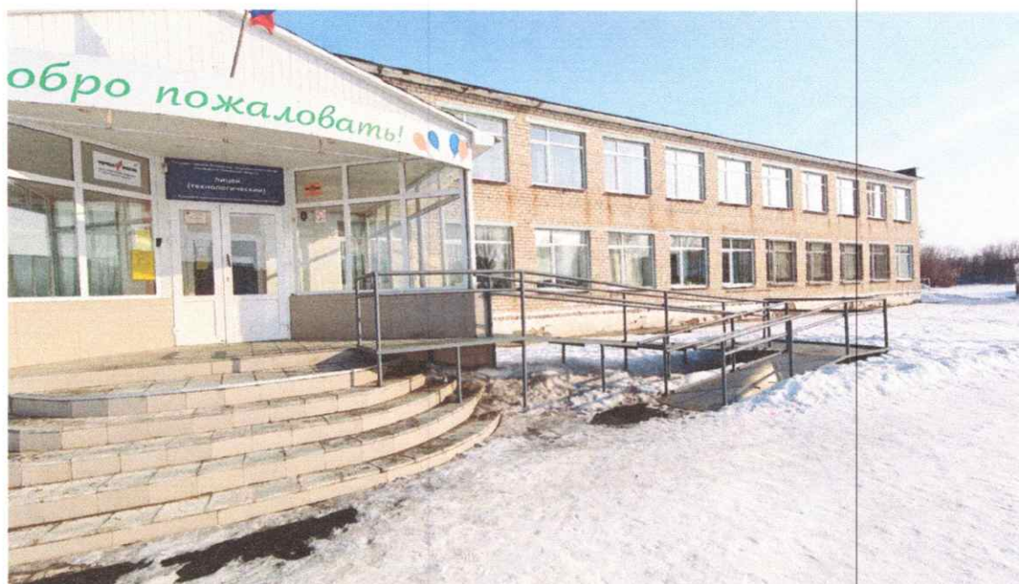
Фото №3 Навес, водоотвод, крыльцо, лестница наружная, пандус наружный.
