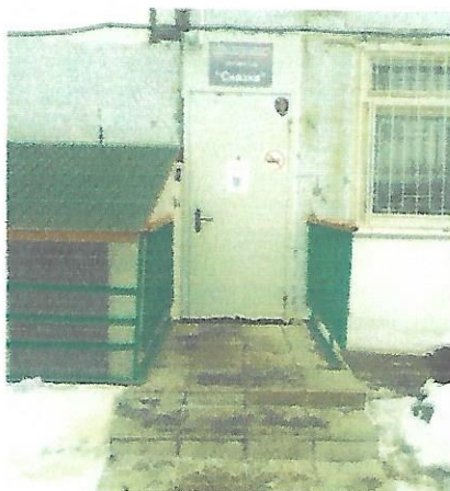
Лестница наружная, входная площадка, дверь входная (на плане №4)
