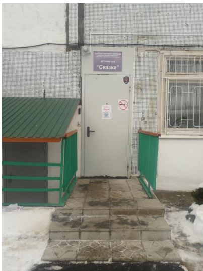
Лестница наружная, входная площадка, дверь входная (на плане №4)
